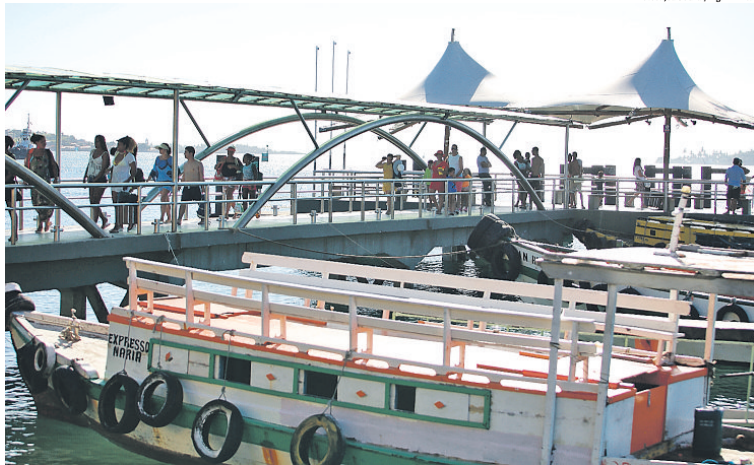
Passarela que dá acesso aos píeres e às pontes para chegar até as embarcações que fazem a travessia para as ilhas
