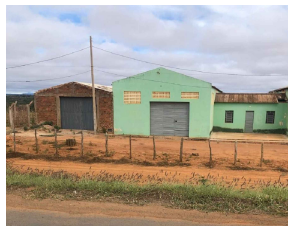
IMAGEM 02 ALOCAR O PÓRТИCO EM FRENTE À ESSA EDIFICAÇÃO
