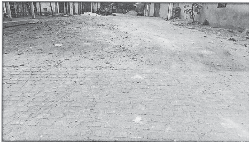
Figura 1 RUA DA CAIXA D'ÁGUA
