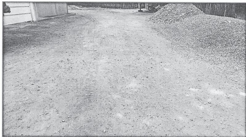
Figura 2 RUA DA CAIXA D'ÁGUA
