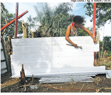
Occupante montava sua casa com material de pvc
