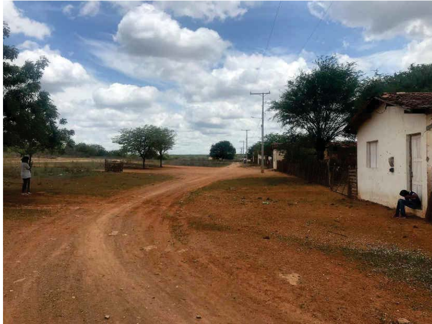
Figura 11 - Parte do trecho a ser melhorado. PA Sacrificio (coord. 225377/ 8782368)
