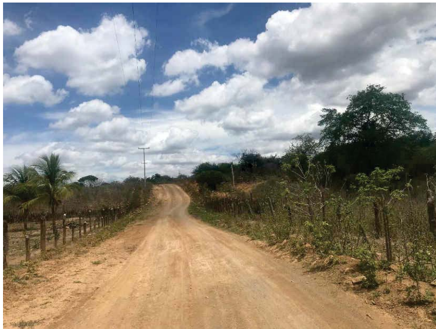
Figura 10 - Parte do trecho a ser melhorado (coord. 224232/ 8780466)
