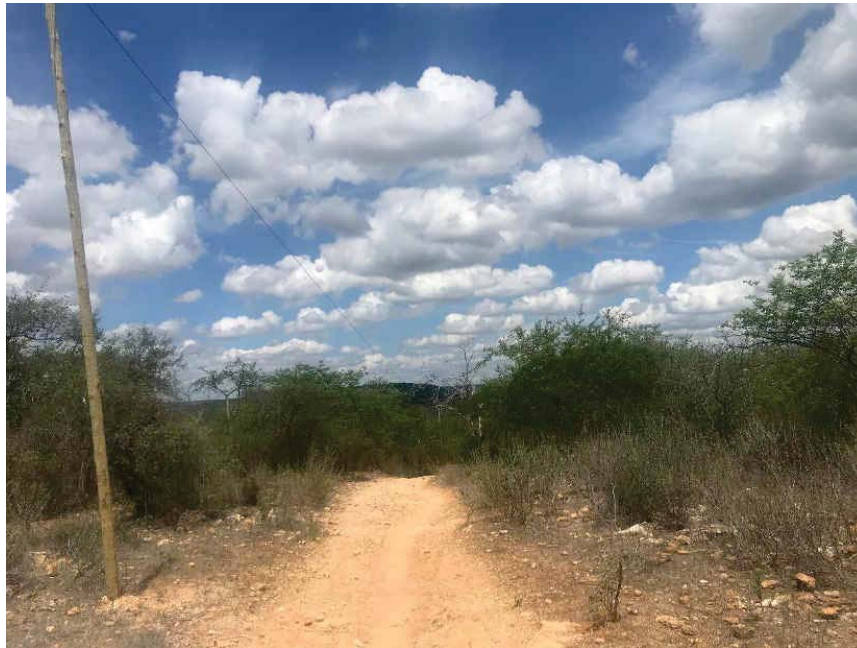
Figura 15 - Parte do trecho a ser melhorado (coord. 227582/ 8784136)
