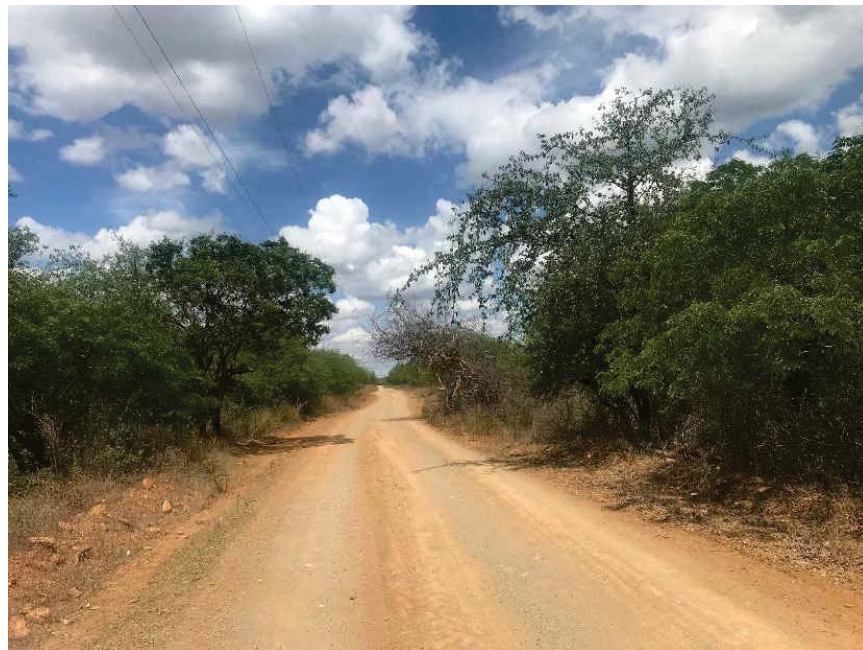
Figura 12 - Parte do trecho a ser melhorado (coord. 225639/ 8782632)
