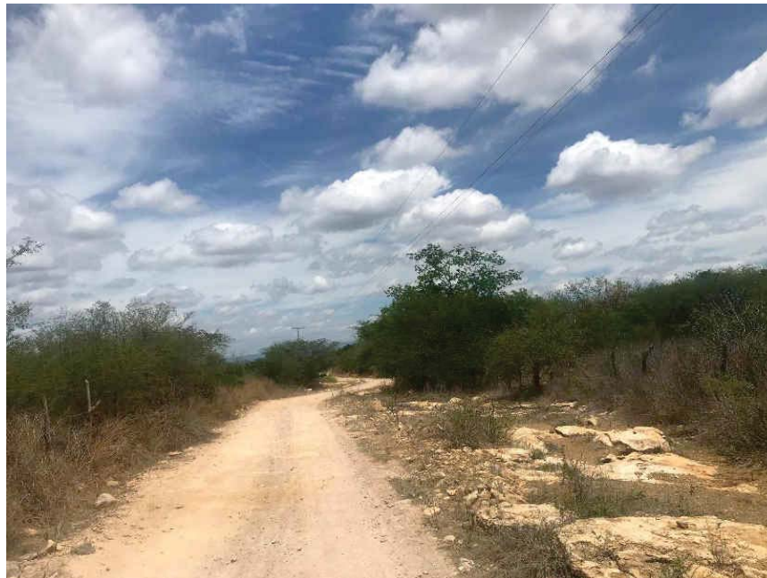
Figura 06 – Parte do trecho a ser melhorado (coord. 218951/ 8777246)
