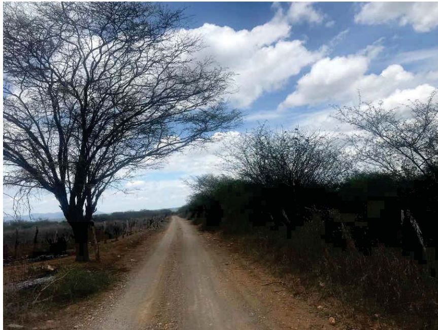
Figura 09 - Parte do trecho a ser melhorado (coord. 220510/ 8779024)
