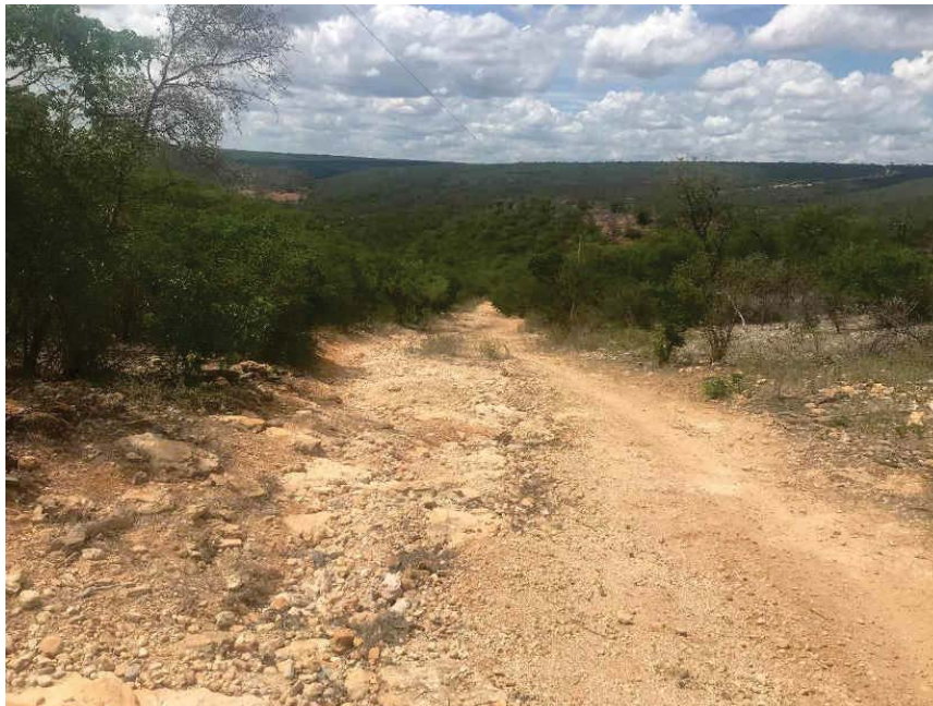
Figura 16 - Parte do trecho a ser melhorado (coord. 227916/ 8784432)
