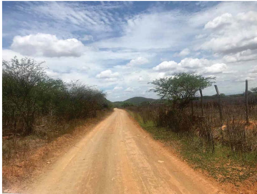
Figura 05 – Parte do trecho a ser melhorado (coord. 217309/ 8776604)
