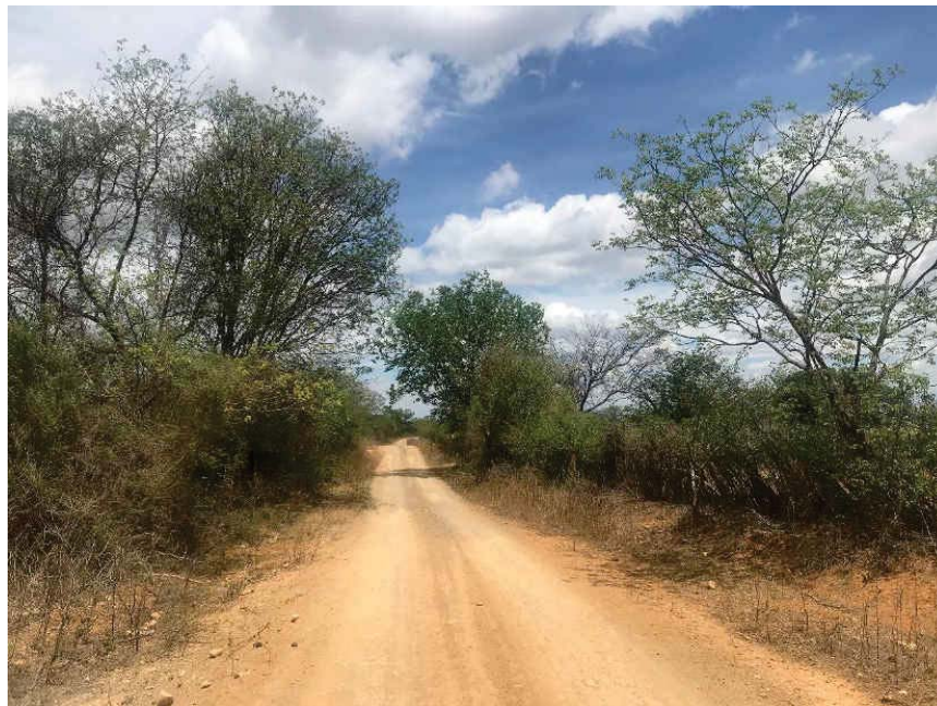
Figura 08 – Parte do trecho a ser melhorado (coord. 219545/ 8777720)
