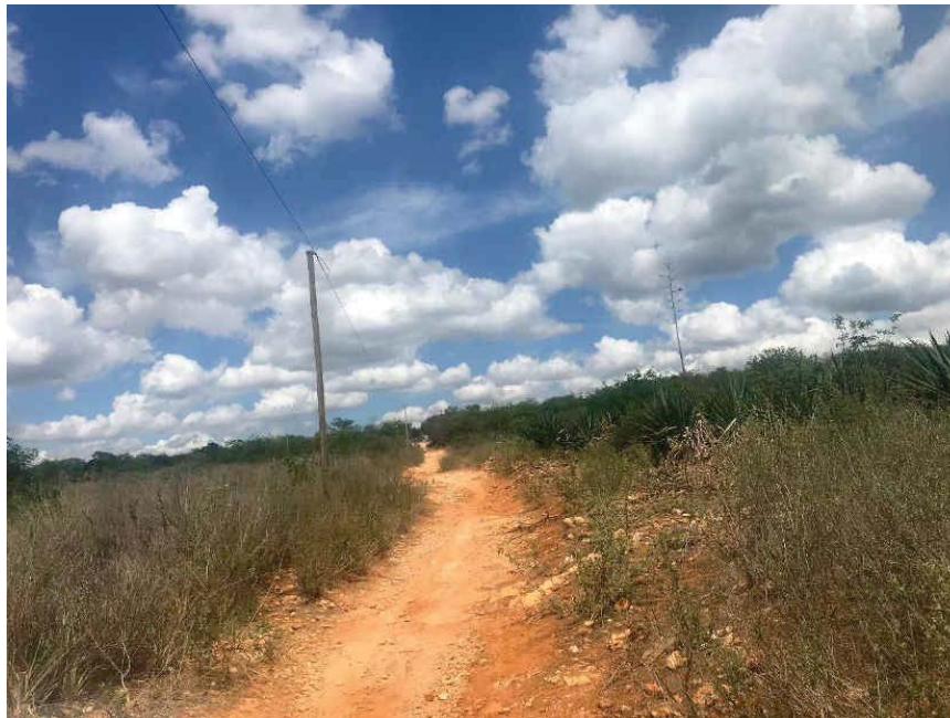
Figura 14 - Parte do trecho a ser melhorado (coord. 227280/ 8783838)
