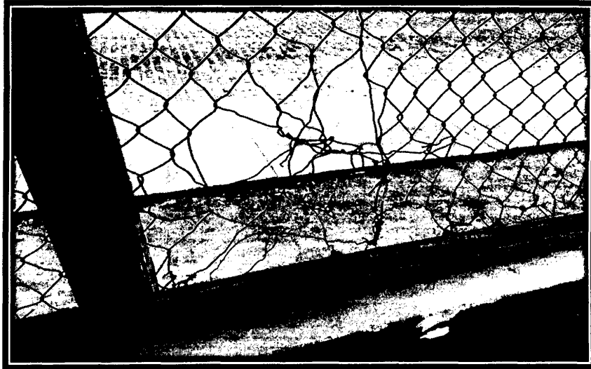
IMAGEM 03 – SITUAÇÃO DA TELA DO ALAMBRADO
