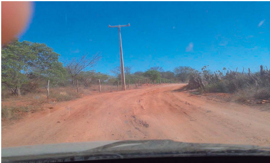
VISTA PARCIAL DO TRECHO LAGOA DE FORA A CURRALINHO
