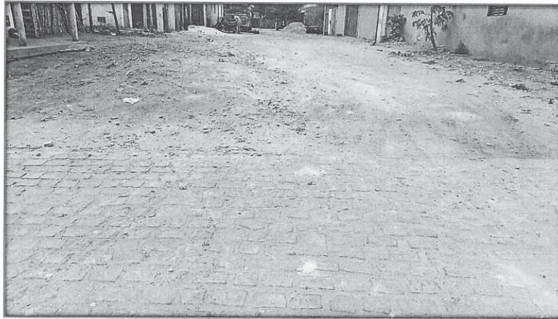
Figura 1 RUA DA CAIXA D'ÁGUA
