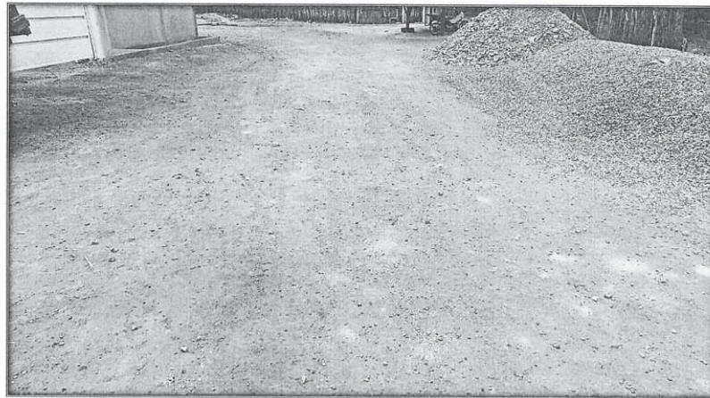
Figura 2 RUA DA CAIXA D'ÁGUA
