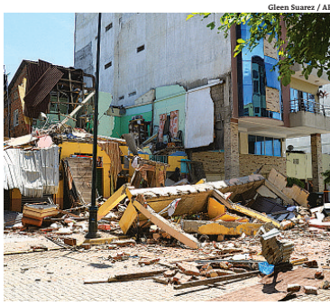
Prédios destruídos no sítio em Machala, Equador
