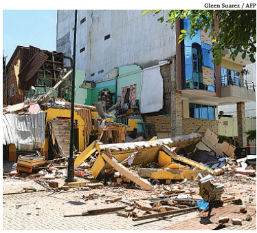
Prédios destruídos no sítio em Machala, Equador
