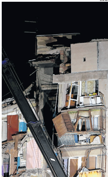
Explosão de gás abalou prédio residencial há três dias
